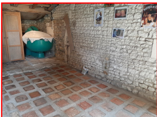
Nous remercions Mme CRAON Arlette qui nous a donné le dallage mis en place par le chantier du petit patrimoine de la CDCHS
